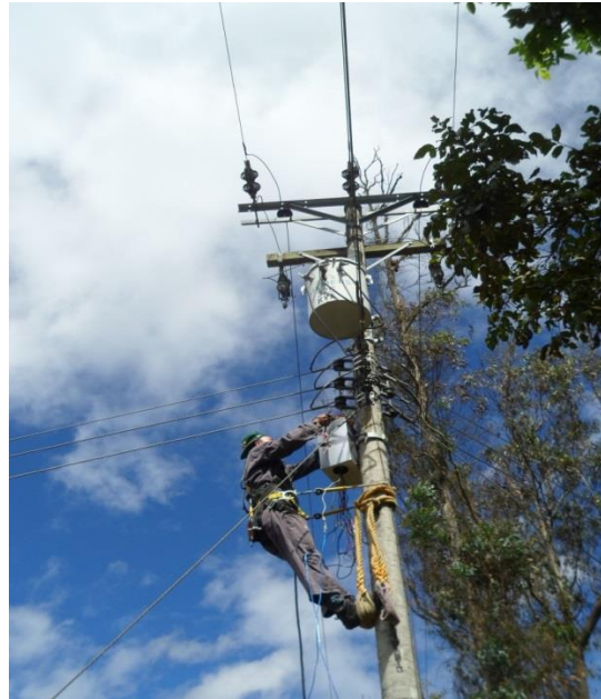
Figura 27. Instalación del analizador de redes en la vereda las Palmas del Municipio de el Tambo.
