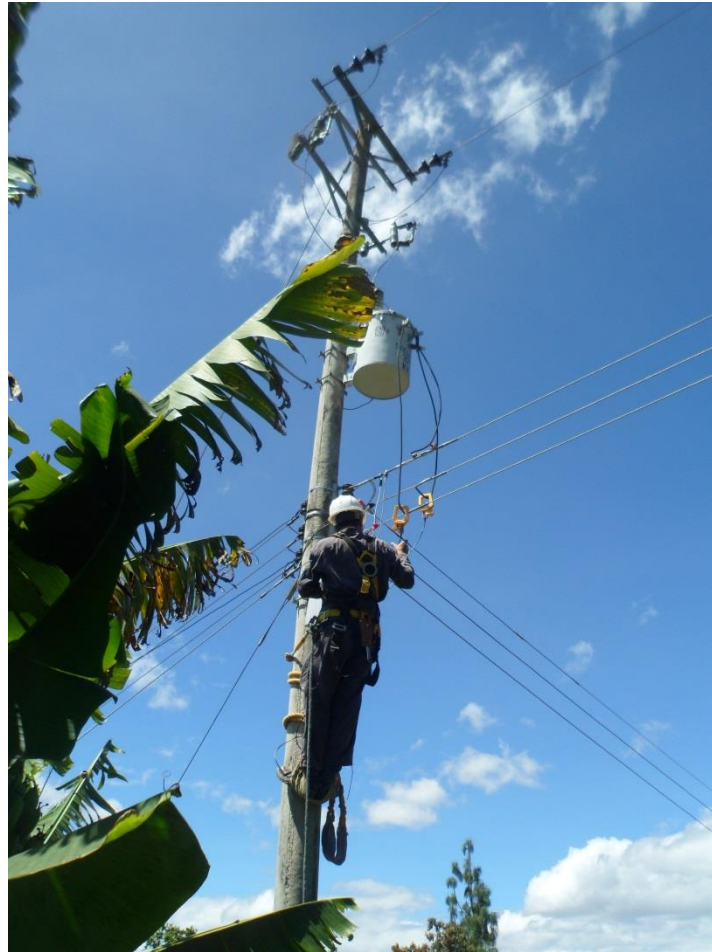
Figura 26. Instalación del analizador de redes
